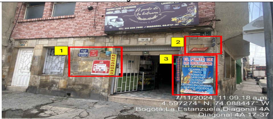
En la cual se evidencian tres (3) elementos PEV adicionales en fachada, identificados con los números 1, 2 y 3.
